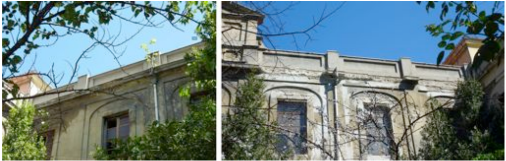
Fotografías del estado de las cornisas del Jardín central, antes y después de la intervención (realizada por empresa especializada en trabajos verticales)
