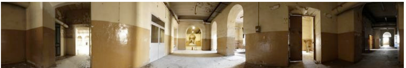
Fotografía del estado de la zona Postnave en febrero de 2010
